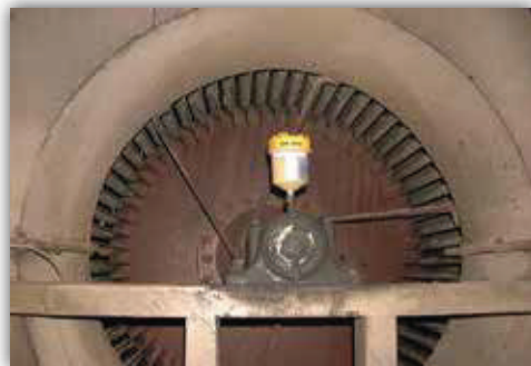
La grasera Streamliner® V instalada en un soplador
