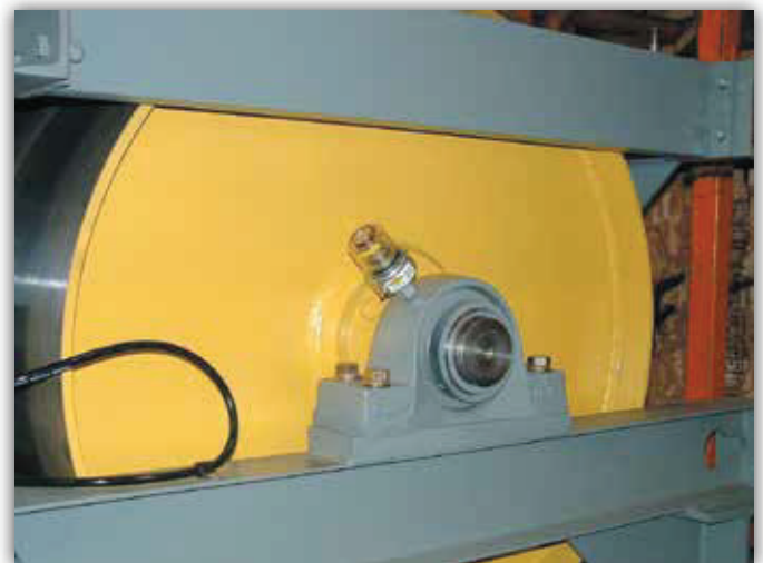
Grasera instalada en un bloque de un dinamómetro
